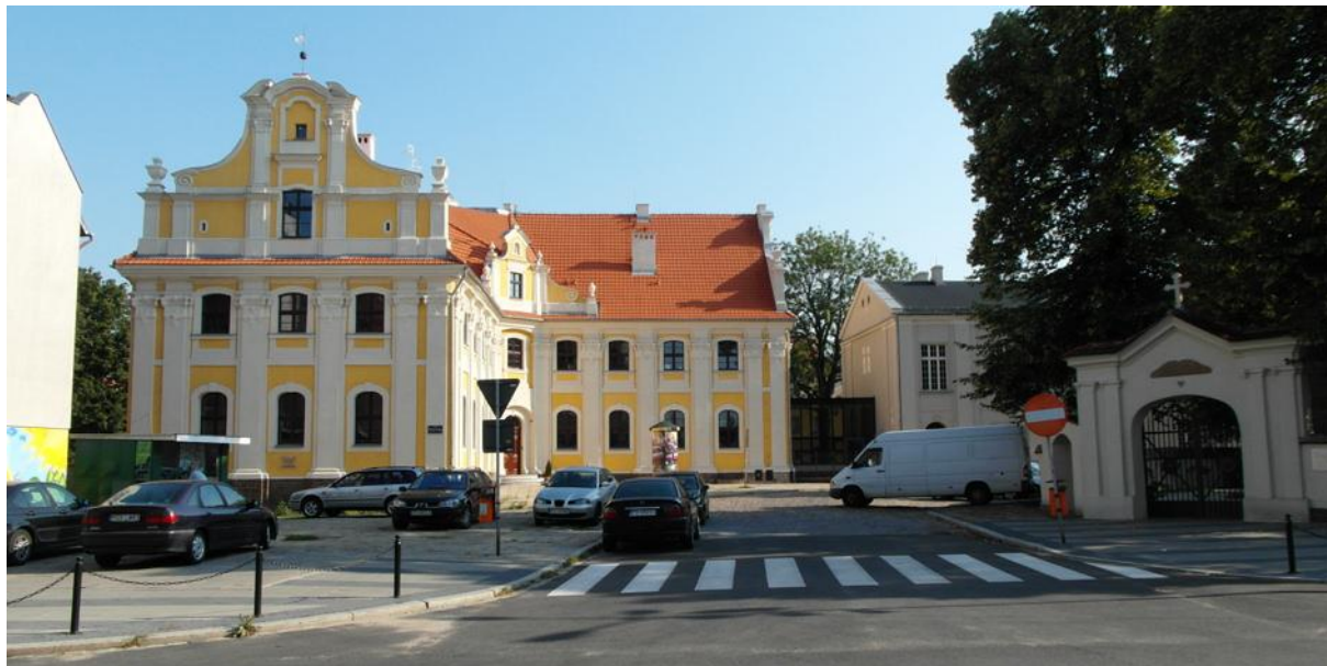
Fot. 5. Klasztor Filipinów na Śródcie po adaptacji i renowacji, 2012. Zdjęcie: L. Podbrez
