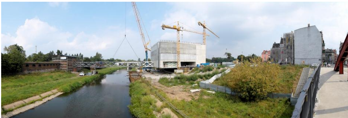
Fot. 7. Budowa Interaktywnego Centrum Historii Ostrowa Tumskiego, 2012 r. Zdjęcie: L. Podbrez
